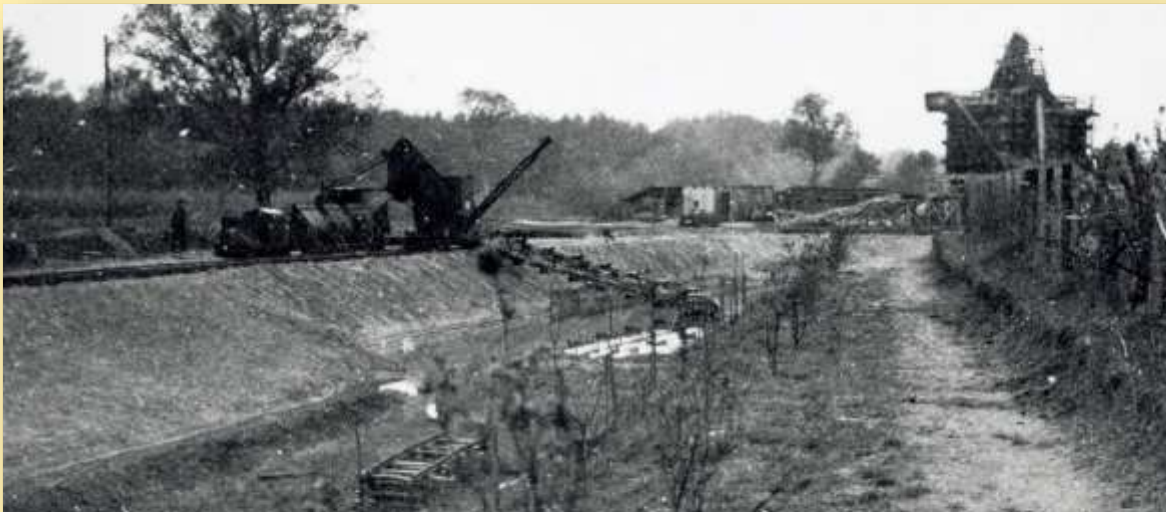
Kiesgewinnung mit dem Schaufelbagger bei F.H. Drewes um 1939. Rechts ist im Hintergrund das Gebäude der Kieswäsche zu sehen, heute Wohnhaus Ohligschläger. Links im Bild die Abbaufäche auf dem Gelände hinter dem Wohnhaus Drewes. Das Baggergut wurde mit Loren transportiert und dann auf Züge verladen.
